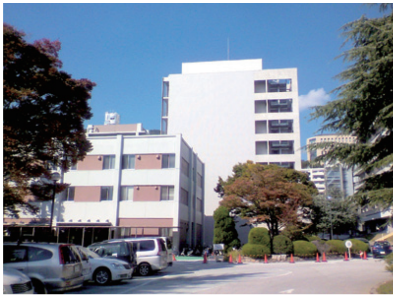
自然科学総合研究棟4号館
