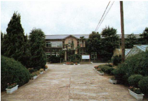
兵庫県農業総合センター（戦時中に日本館は焼失、1947年に再建築）
