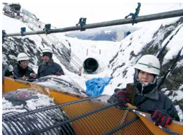
パイプラインの現場埋設実験（農林水産省）
