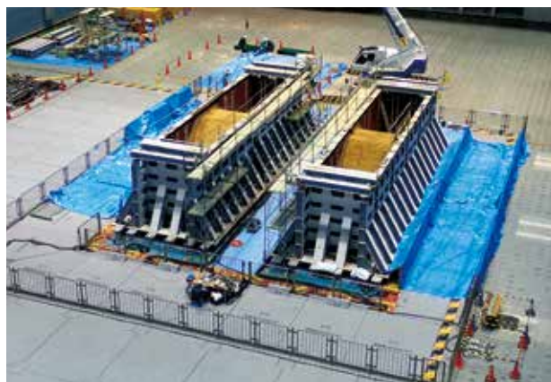
実大規模のため池堤体振動実験（E-ディフェンス）
