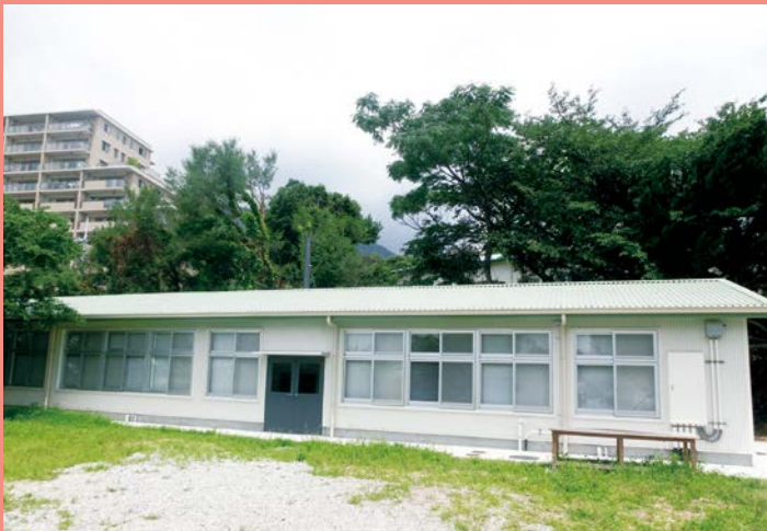
農産加工工場 (2016 年度耐震工事)
